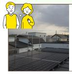
金属屋根掴 み金具工法 で雨漏りリ スクを軽減 でき、設置 費用も安価
