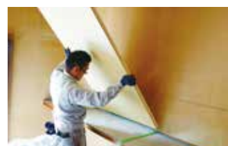
既存壁の内側からボード取付け
