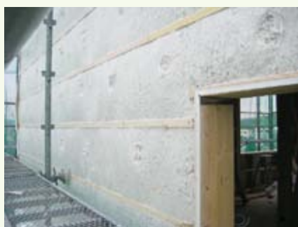
壁の断熱材（壁厚 200mm）
