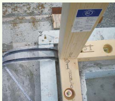
基礎断熱による基礎と土台の気密
