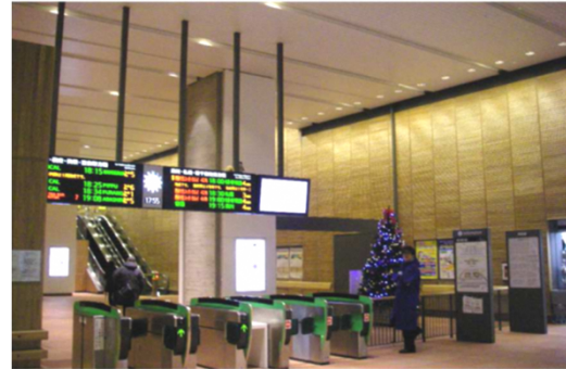
写真1 防火木材の施工事例 (道産ヤチダモ材, JR旭川駅舎)
